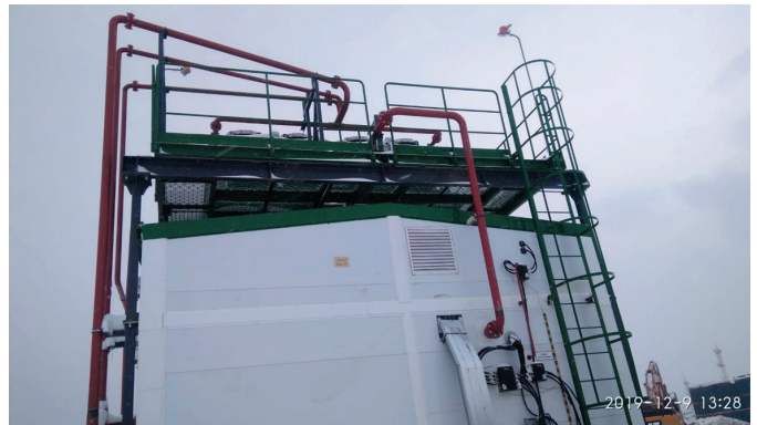
Нагнетательные трубопроводы системы холодоснабжения
