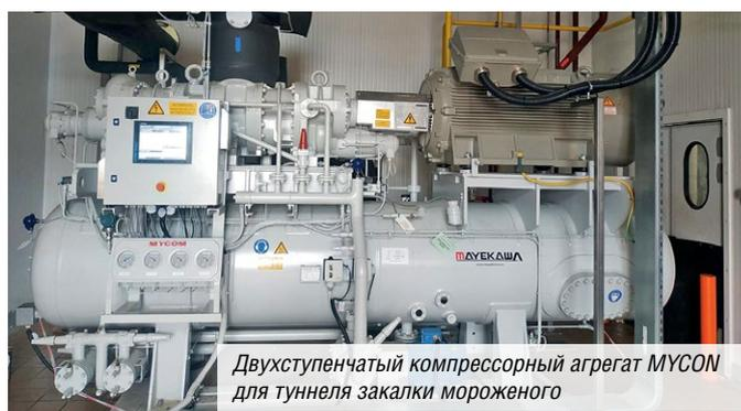
Двухступенчатый компрессорный агрегат МУСОМ для туннеля закалки мороженого
