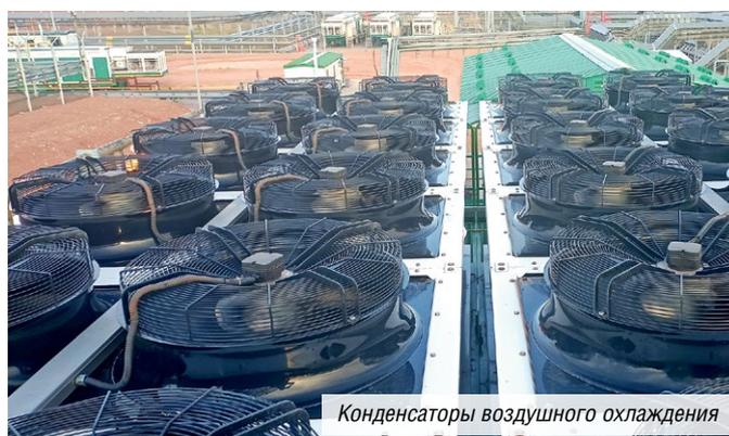
Конденсаторы воздушного охлаждения
