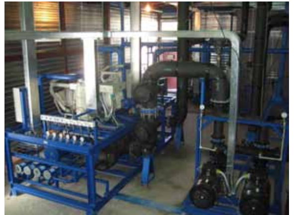
Установка ледяной воды и гидромодуль в машинном отделении
