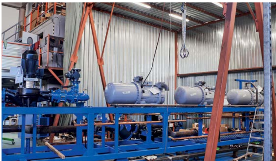
Сборка холодильной установки в сборочном цехе ООО «Фриготрейд»
