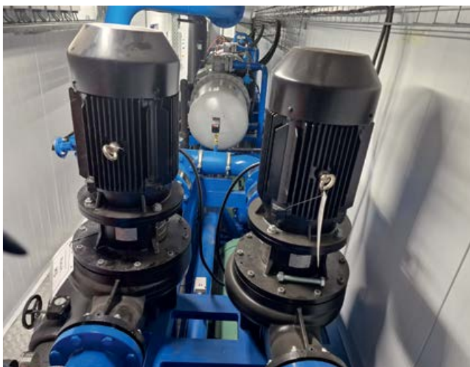
Насосный агрегат на общей раме с компрессорами после установки в контейнер
