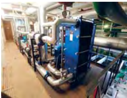
Разборный пластинчатый теплообменник системы фрикулинга
